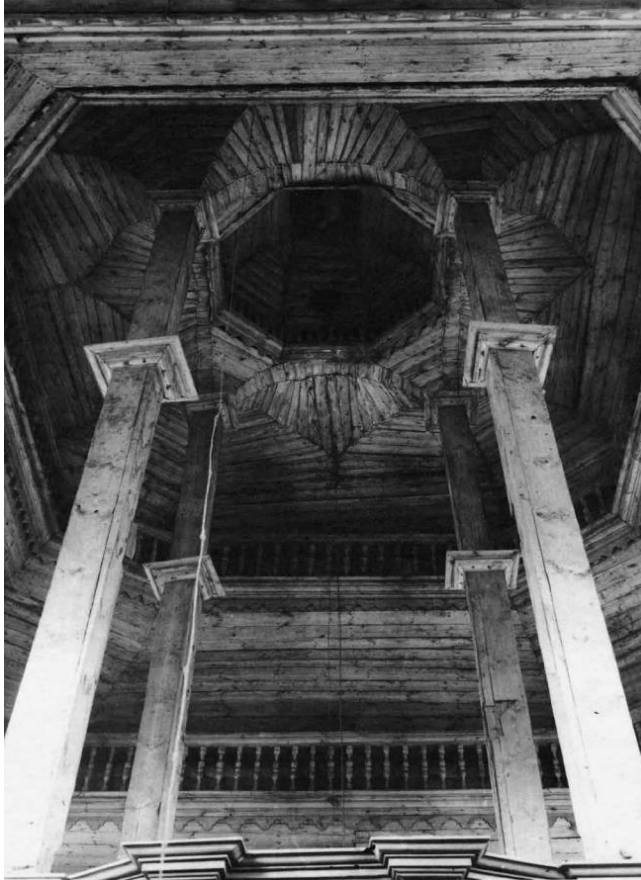
więźba dachowa (Źródło: Bramy Nieba)
